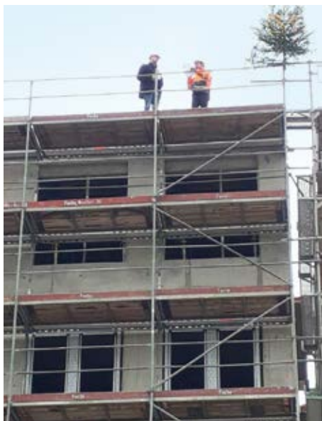
Richtfest Erweiterungsbau Landratsamt am 30. November 2018.
