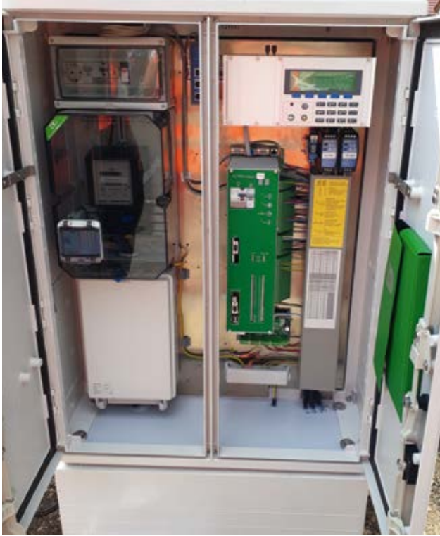
Steuerungstechnik einer Signalanlage
