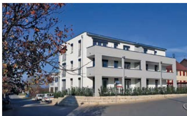
Dürnau, Jurastraße 11 Mehrfamilienhaus mit 11 Wohnungen Baubeginn: 2017, Fertigstellung: 2018
