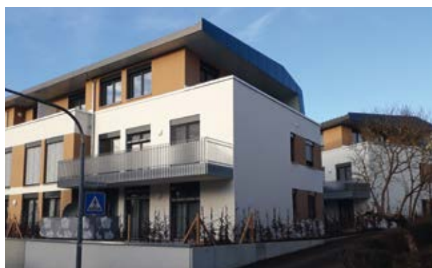
Schlierbach, Hattenhofer Straße 45 und 45/1 2 Mehrfamilienhäuser mit jeweils 8 Wohnungen Baubeginn: 2017, Fertigstellung: 2018
