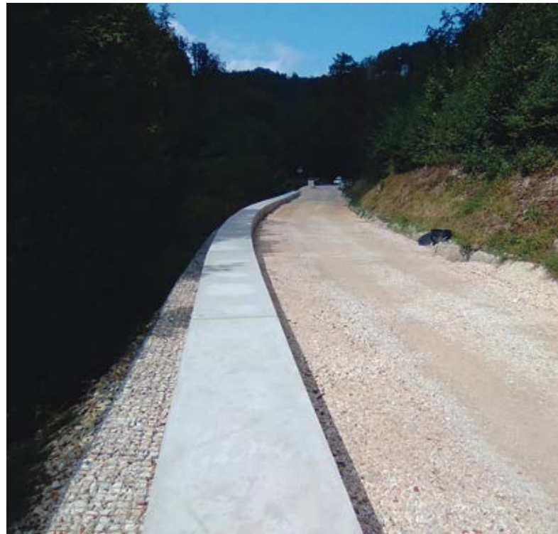
Der neue Aufbau der Straße oberhalb der Eyb mit einem massiven Blocksteinsatz: Die baufällige Stützmauer an der Zufahrt zum Wanderparkplatz am Mordloch wurde mit Natursteinen wiederhergestellt. In Abstimmung mit dem Naturschutz sind in den Fugen Hohlräume berücksichtigt, die als Brutplätze für Gebirgsstelzen dienen.
