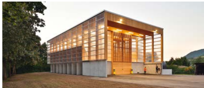
Ansicht Südwest – Salzlagerhalle Geislingen
