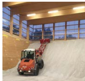
Innenansicht – Salzlagerhalle Geislingen
