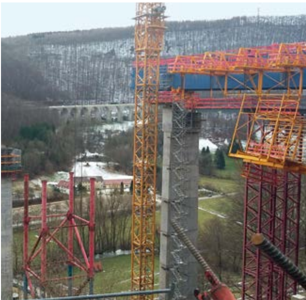
Neubaustrecke S21 – Filstalbrücke, Blickrichtung Nord/West
